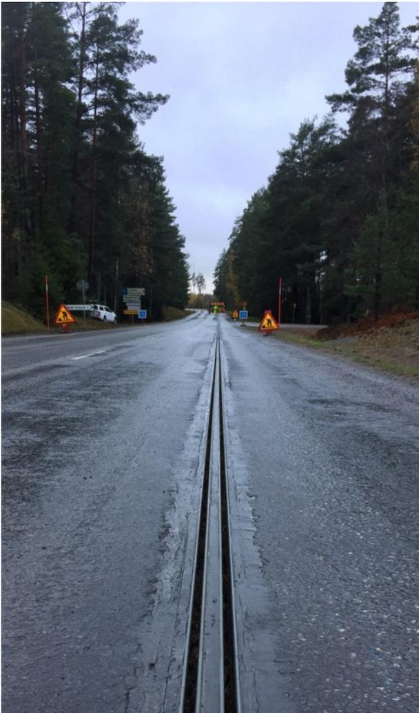
**Photo 1 : Le rail Elways équipant le projet pilote de e-Road Arlanda en Suède.** *Source : Elways.*
