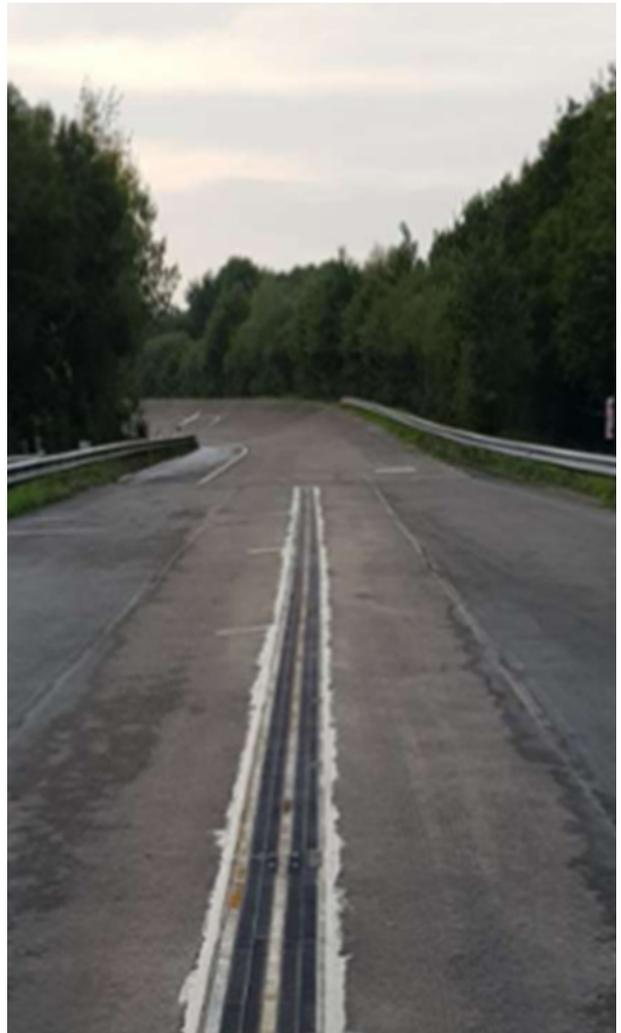
**Photo 2 : Système Alstom avec double rail intégré dans la route.** *Source : Alstom*
